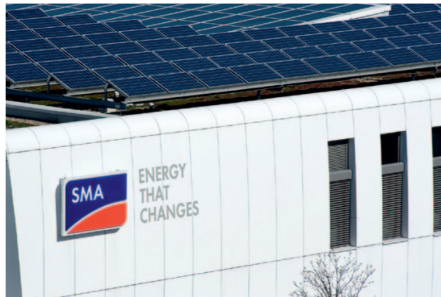
Eine PV-Anlage mit 1,1 GWp versorgt die Produktion umweltfreundlich mit Strom
