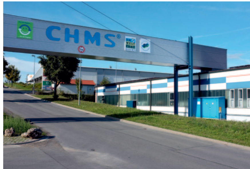
CHMS ist Schritt für Schritt auf dem Weg zur ersten abwasserfreien Wäscherei Deutschlands
