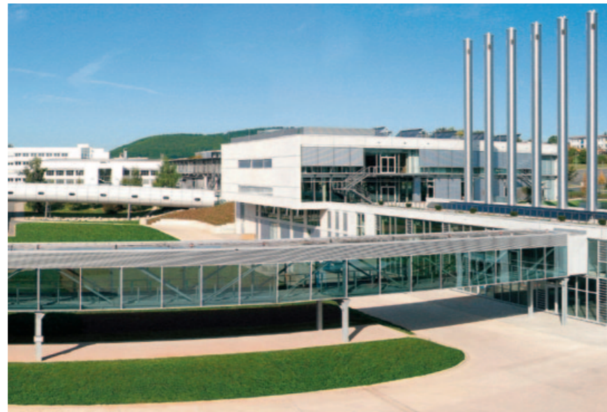
In der Energiezentrale in Allendorf (Eder) werden Öl und Gas, Biomasse, Sonnenenergie sowie Wärme aus der Luft und dem Erdreich genutzt
