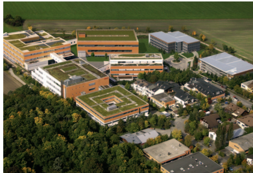
Die Schreiner Group setzt im neuen Gebäude auf Wärme-erzeugung durch Geothermie
