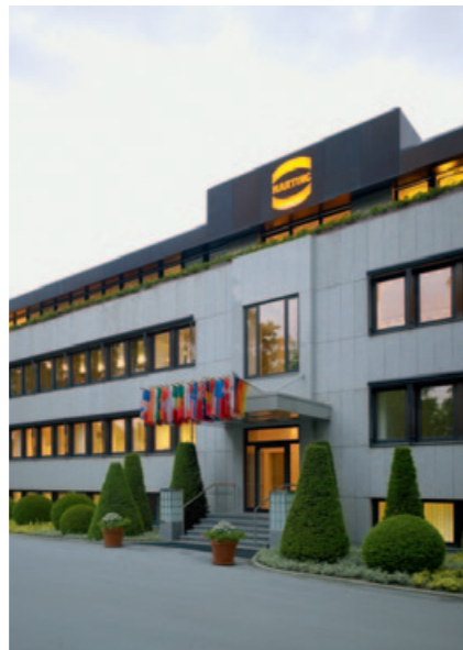
Hauptgebäude Werk 1 (l.) Heizzentrale Werk 2 (r. o.) und Heizzentrale Werk 1 mit WW-Heizkessel und BHKW (r. u.)
