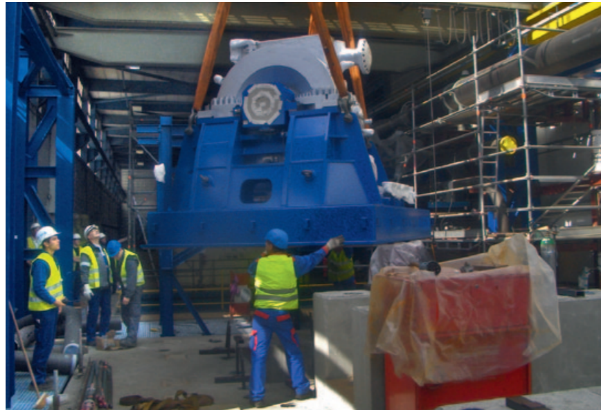
Austausch einer Kraftwerksturbine für eine effizientere Energieerzeugung
