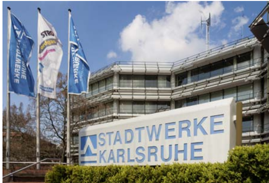
Über zwei Jahre wird das Verwaltungsgebäude der Stadtwerke energetisch saniert.
