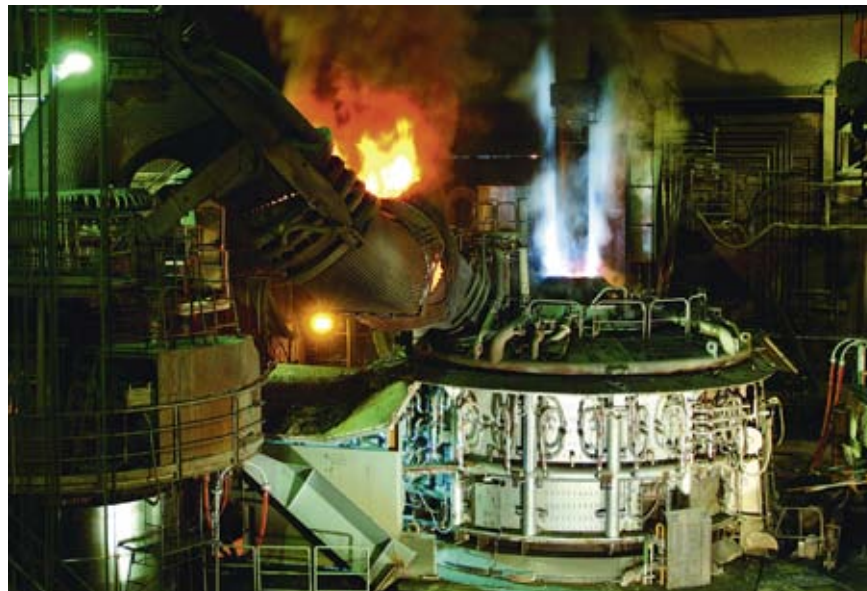
Herzstück und einer der Hauptverbraucher der Georgsmarienhütte GmbH: Der Gleichstrom-Elektrolichtbogenofen.
