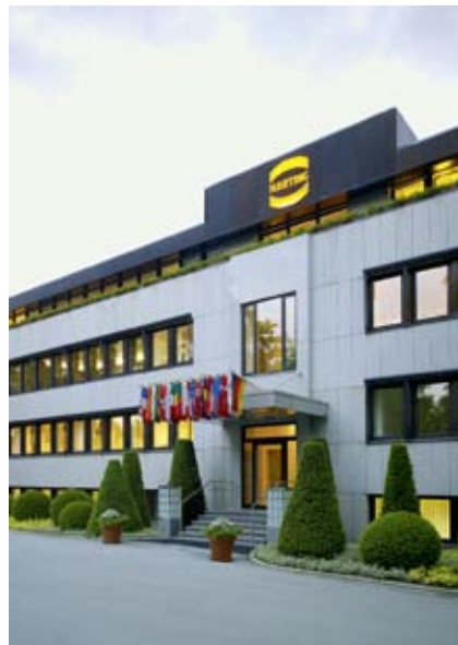
Hauptgebäude Werk 1 (l.), Heizzentrale Werk 2 (r. o.) und Heizungszentrale Werk 1 mit WW-Heizkessel und BHKW (r. u.).
