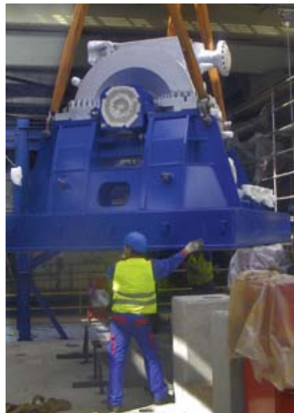
Austausch einer Kraftwerksturbine für eine effizientere Energieerzeugung.
