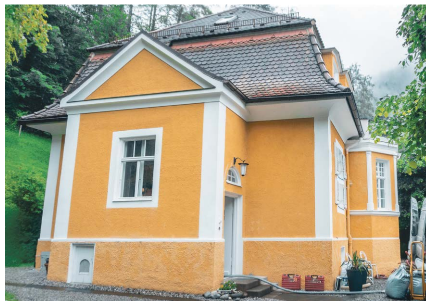
Dämmung einer Altbau-Villa mit Insute 25-pro bei Erhalt der historischen Fassade
